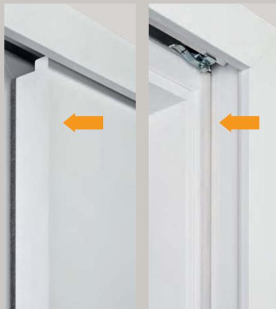
Mit der Streichbürste am Türblatt (Abbildung links) und der optionalen Einlaufdichtung in der Zarge (Abbildung rechts) bieten Ihnen die vor der Wand laufenden Schiebetüren mit Zargentyp C einen optimalen Schutz vor Gerüchen, Lärm und Zugluft – so fühlen Sie sich in Ihren vier Wänden noch wohler.
